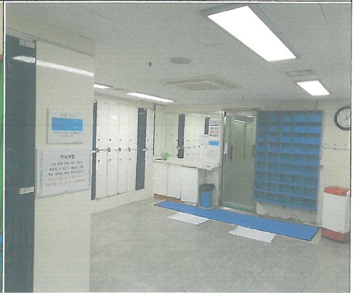
수영장 남자 탈의실 전등기구 전체 전선교체
