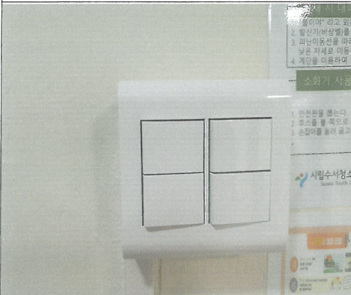
수영장 남자 탈의실 전등 스위치 교체
