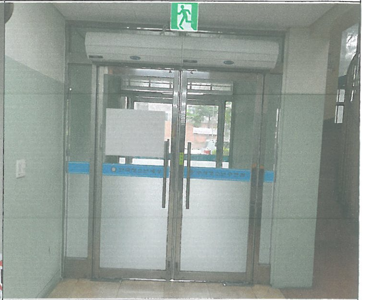
1층 주차장방향 복도 출입 강화문 손잡이 탈락 보수
