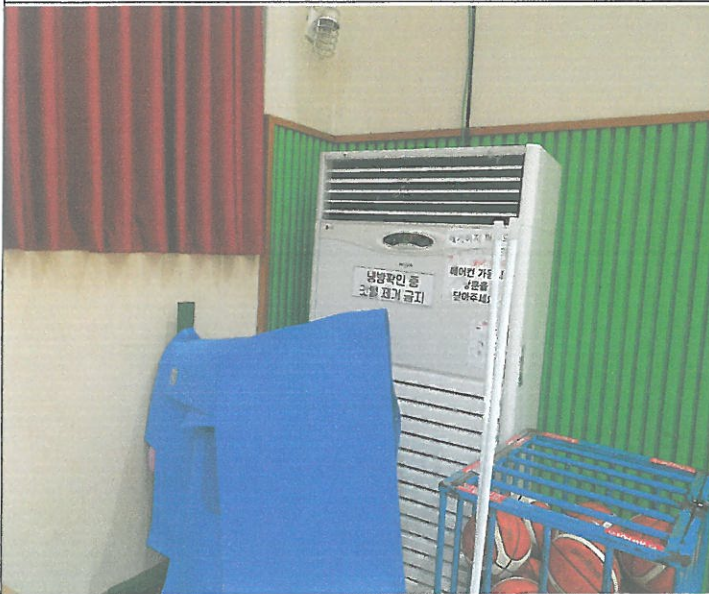
대 체육관 창가 쪽 에어컨 필터 막힘 물 넘침 드레인 배관 이물질 청소
