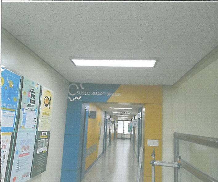
2층 유스 복도 천장 등 1개소 교체
