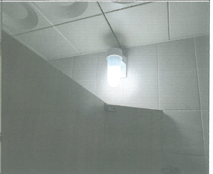
지하2층 남자 샤워장 벽등 1개소 교체
