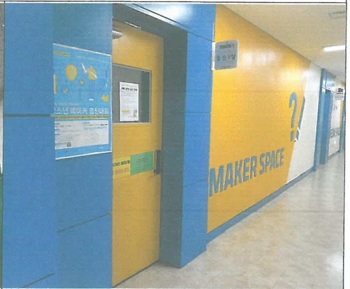
2층 유스1실 출입 방화문 닫힘 불량 교정
