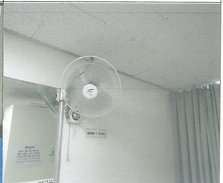
수영장 여자 탈의실 입구 선풍기 작동 불량 해체 수리 부착
