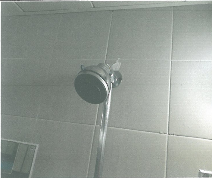
수영장 여자 샤워실 샤워기 헤드1기교체
