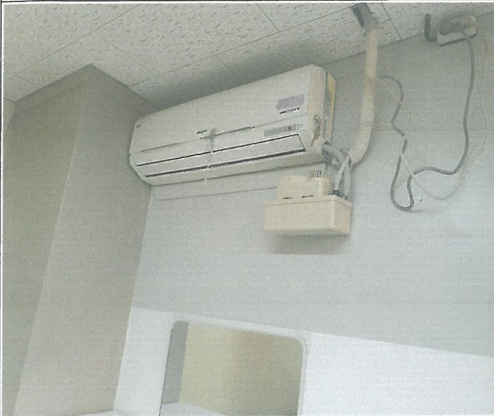
2층 유스 아지트 에어컨 응축수 누수 배수로 각도교정
