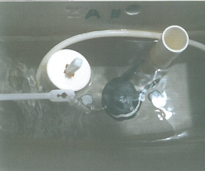
수영장 여자 샤워실 화장실 변기 수위조절봉 수거 보수
