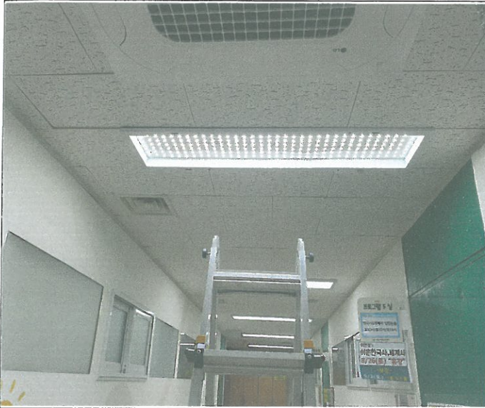
2층 상담복지 센터 복도 천장등 1개소 제 결선
