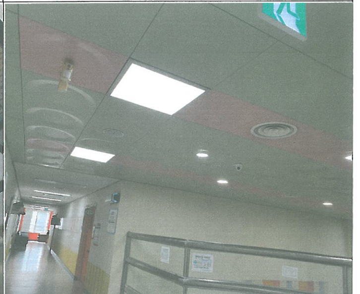
3층 복도 중앙 천장 매립등 사각 안전기 교체
