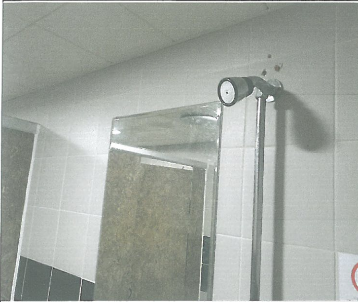
수영장 내부 화장실 샤워기 노즐 교체
