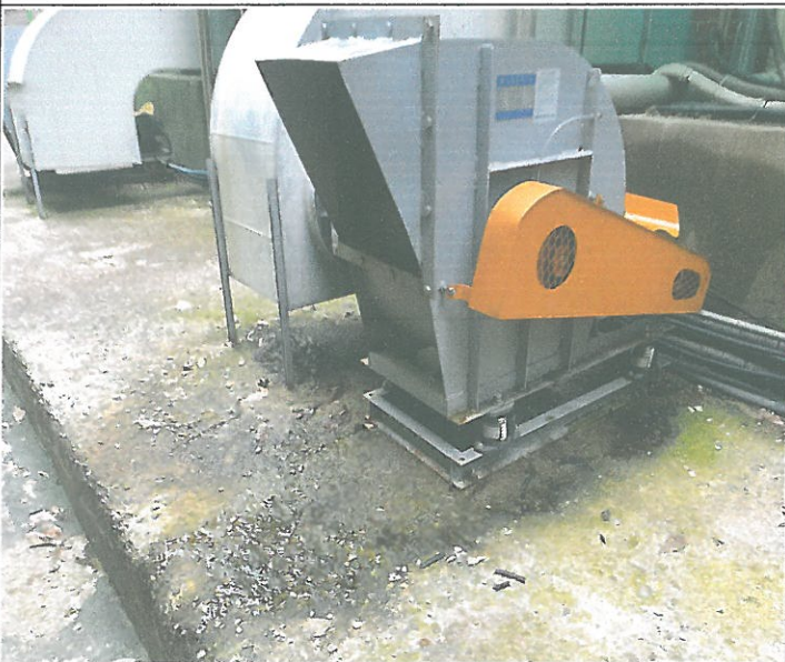
수영장 샤워실 배기팬 브이벨트 A-58 교체
