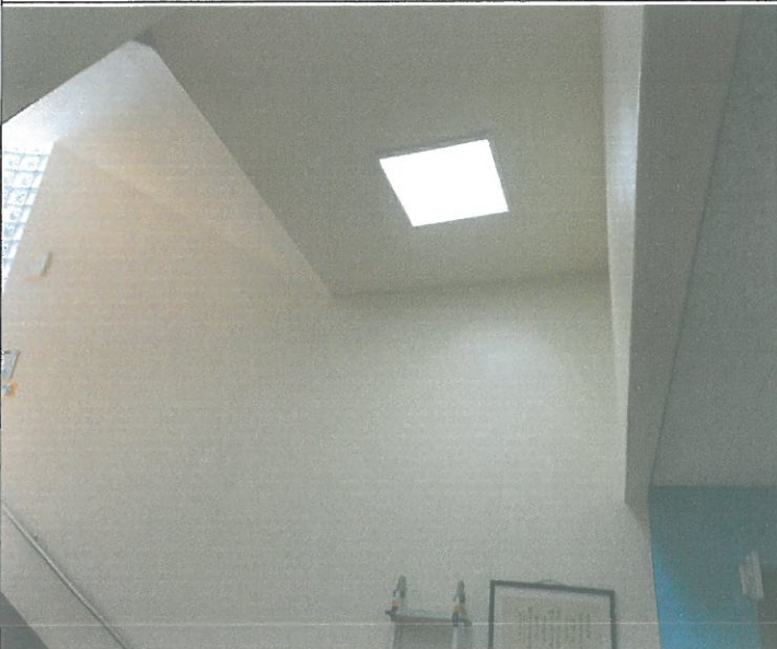
2층 중앙 계단 사각 등 1개소 교체
