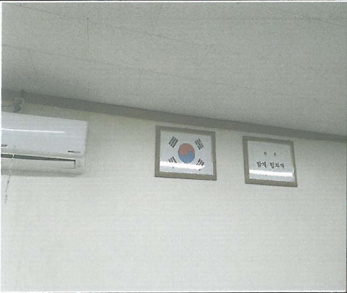
3층 헨델실 천장 물딩 탈거 되어 제부착
