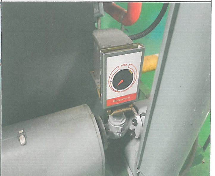
기계실 온수 열교환기 모듈트롤모터 작동 불량 A/S 부품 교체 정상 가동
