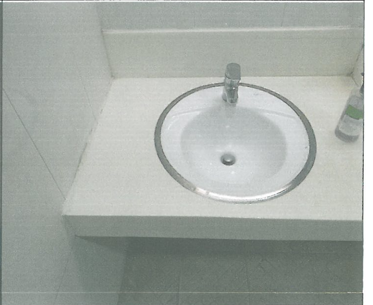
1층 여자 화장실 세면대 막힘 통수
