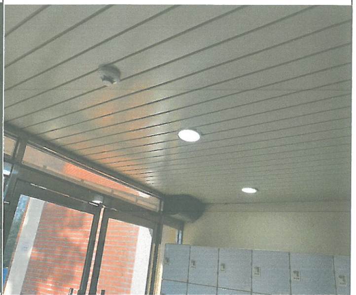
1층 자판기 방풍실 천장 다운라이트 1개소 교체
