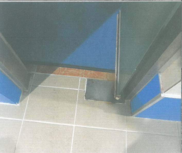
수영장 여자 샤워실 계단방향 강화문 하부힌지 커버 변형 점검 보수
