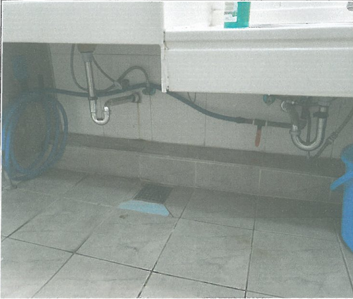
1층 남자 화장실 세면대 P트랩 교체
